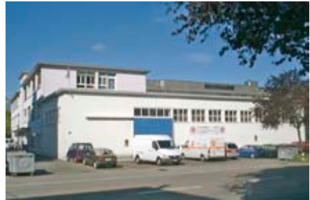
Lagerhalle Rautistrasse 19 in Zürich
